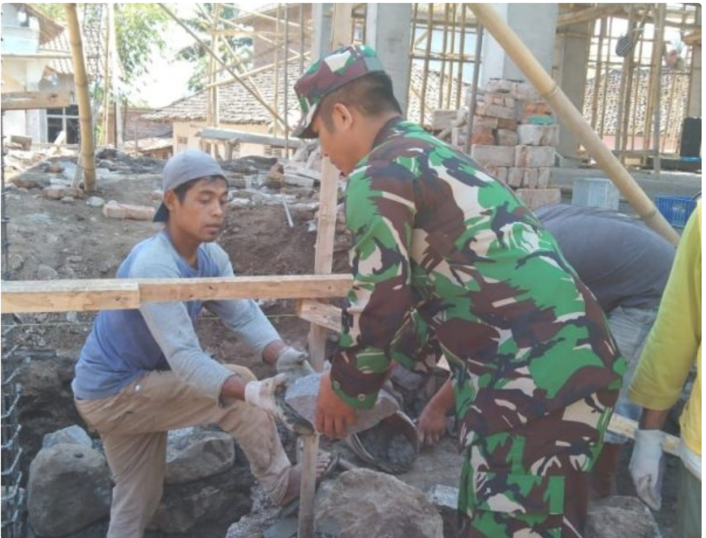
Serda Nasikin bantu pemasangan batu pondasi masjid
